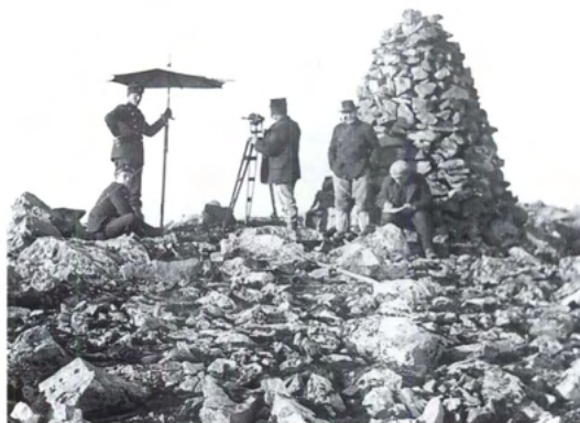
Triangulationsmåling i station med stor varde.
